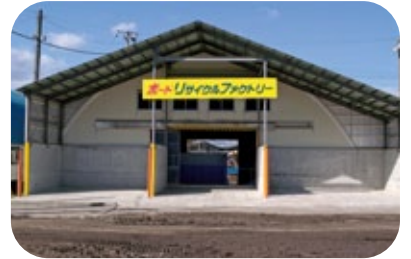
石膏ボードプラント外観
